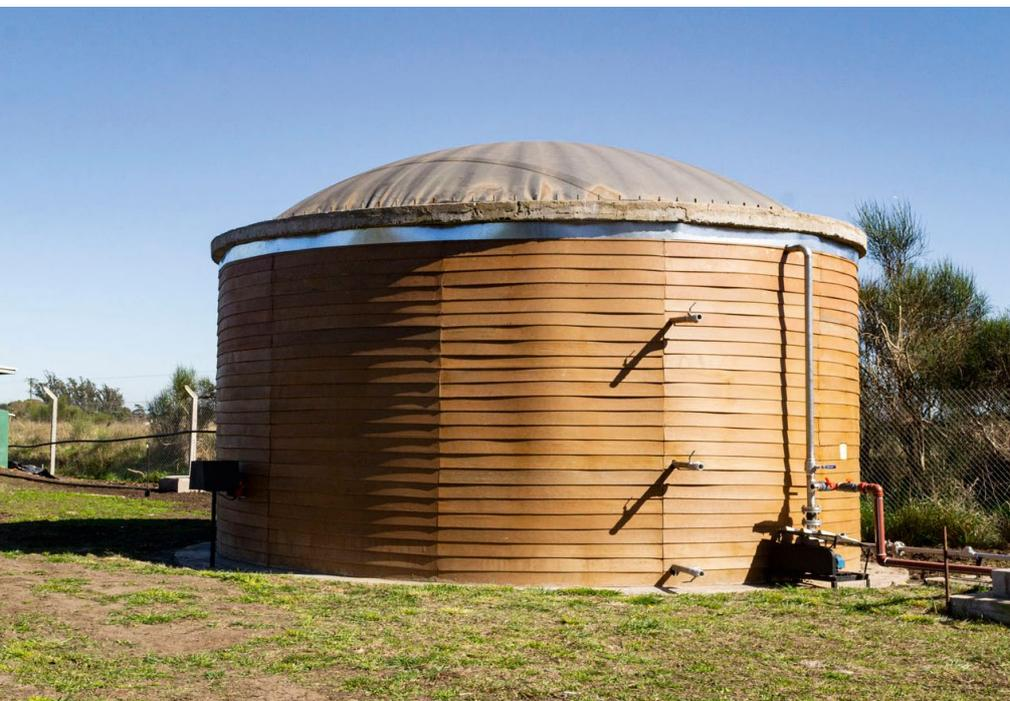
In der 100 Kubikmeter großen anaeroben Vergärungskammer der Biogasanlage vergären organische Abfälle. Die angeschlossene Heizeinheit sorgt für entsprechende Bedingungen zur optimalen Gasproduktion. Quelle: INTA
